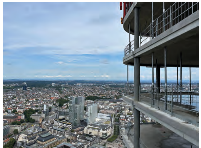
Bild 13 T1: Blick auf die Deckenkonstruktion in Halfertigteilbauweise (Quelle: ATW FOUR)
