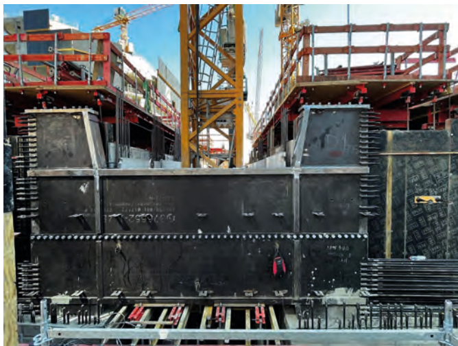
Bild 15 T1: Koppelriegel – eingebauter Zustand (Quelle: ATW FOUR) T1: Linked beams – installed condition
